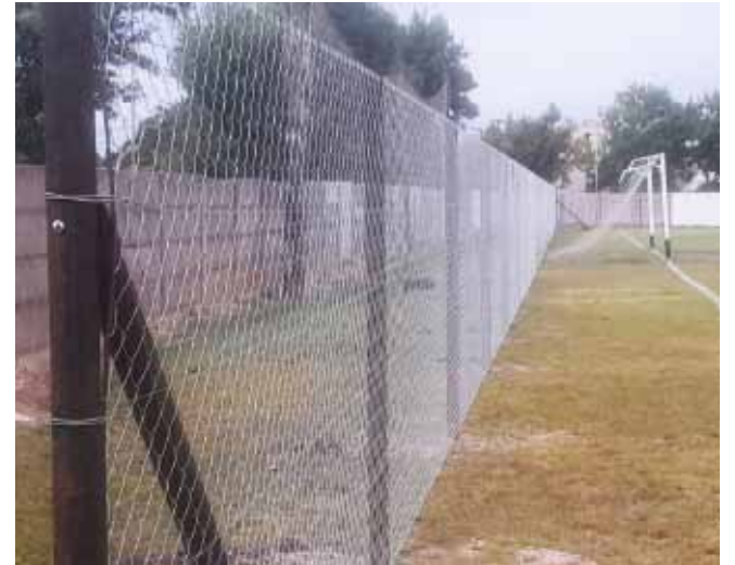
El alambrado perimetral de la cancha, equipamiento, luminarias, son algunas de las obras realizadas.
